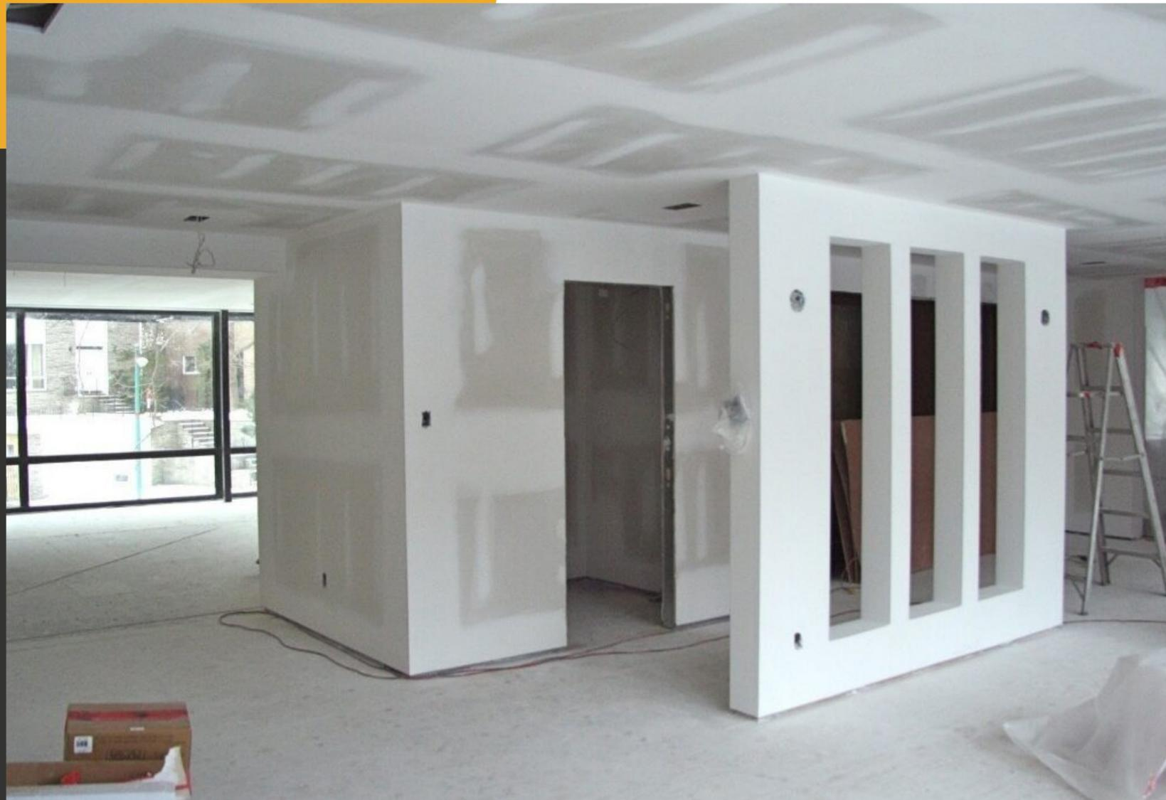
La construcción en seco o Drywall, es un sistema constructivo liviano el cual está compuesto por una perfilería en lámina galvanizada y placas de yeso, En su aplicación final consta de un refuerzo de masilla y cinta en las uniones de las placas de yeso.
